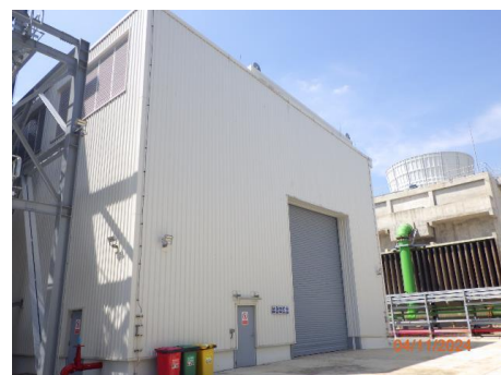
ภาพที่ 2.2-10 ตัวอย่างการติดตั้งอุปกรณ์ที่ทำให้เกิดเสียงดังในห้องปิดของนิคมของโรงงานภายในนิคมอุตสาหกรรมเอเชีย
