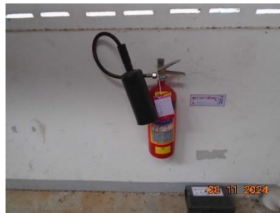
ถังดับเพลิงชนิด CO 2 (Fire Extinguisher)
