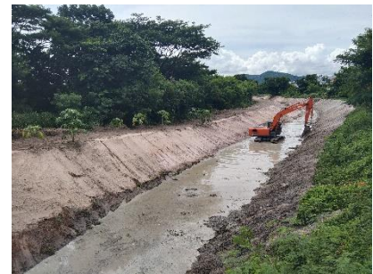
ภาพที่ 2.2-14 การทำความสะอาดและลอกตะกอนในรางระบายน้ำฝนในพื้นที่นิคมฯ
