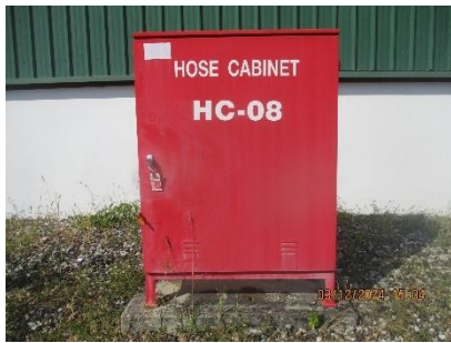
ตู้เก็บสายดับเพลิง (Fire Hose Cabinet)
