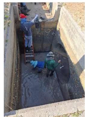
ภาพที่ 2.2-14 การทำความสะอาดและลอกตะกอนในรางระบายน้ำฝนในพื้นที่นิคมฯ
