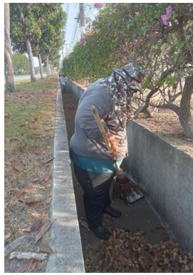
ภาพที่ 2.2-14 การทำความสะอาดและลอกตะกอนในรางระบายน้ำฝนในพื้นที่นิคมฯ
