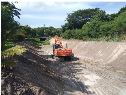
ภาพที่ 2.2-14 การทำความสะอาดและลอกตะกอนในรางระบายน้ำฝนในพื้นที่นิคมฯ
